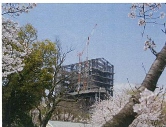
姫山公園から見える姫路城 《平成の大修理を終え工所用鉄骨を撤去中》
